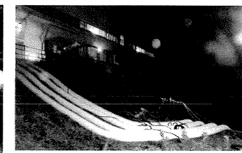
排水作業の状況
