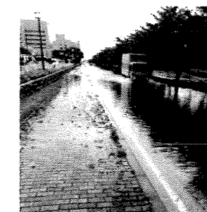
道路冠水の状況
