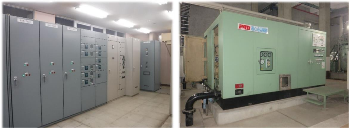
写真 4－3 改築予定施設及び設備
