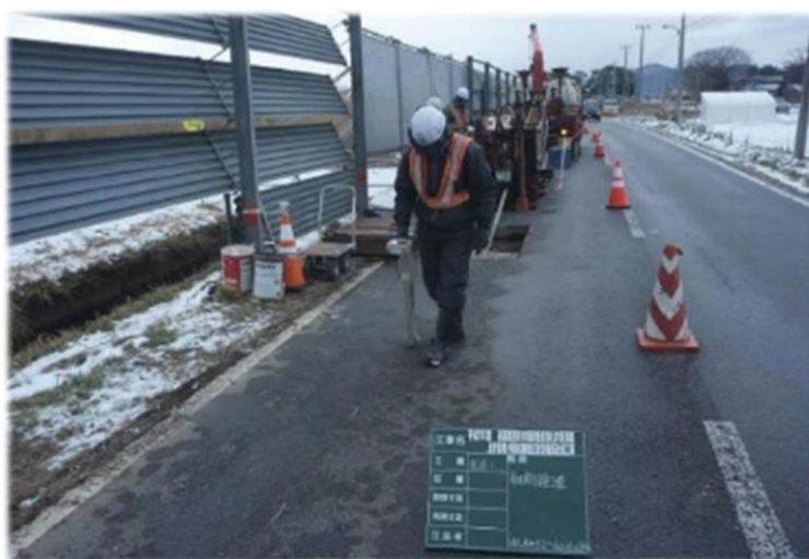
写真 4-6 処理区間を結ぶ接続管路の施工状況
