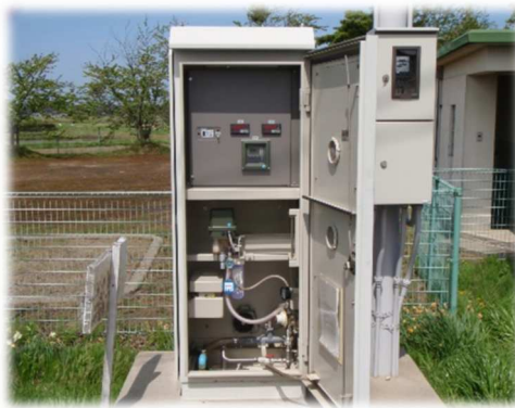
▲監視装置による残留塩素の測定
