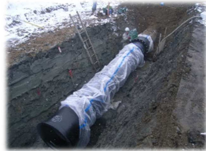
▲基幹管路の耐震管布設 (NS 形ダクタイル鋳鉄管)
