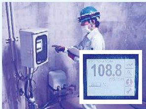
▲塩水遡上対策として小牧浄水場に導電率監視設備を設置
