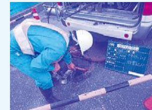
▲計画的に更新や修繕を行うため、下水道管内を調査
