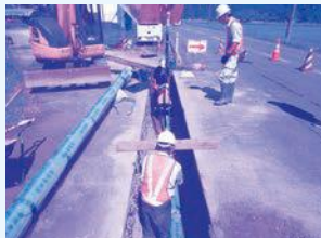
▲古くなった水道管の更新(若浜町、東中の口町、若宮町 他)
