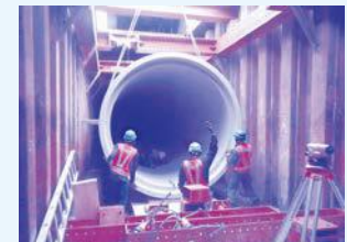
▲豪雨災害に備え、下水道管を整備
