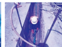
耐震管への更新 (地震対策)
