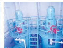
排水ポンプの設置 (浸水対策)
