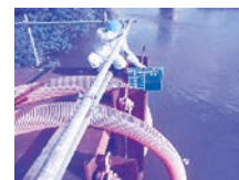
仮設取水設備の設置 (塩水遡上対策)
