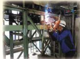
酒田市クリーンセンター脱水汚泥用ベルトコンベア修繕工事
