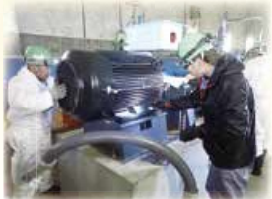
小牧浄水場配水ポンプ整備工事
