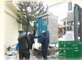
若宮マンホールポンプ制御盤交換工事
