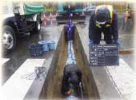
酒田地区配水管改良工事
