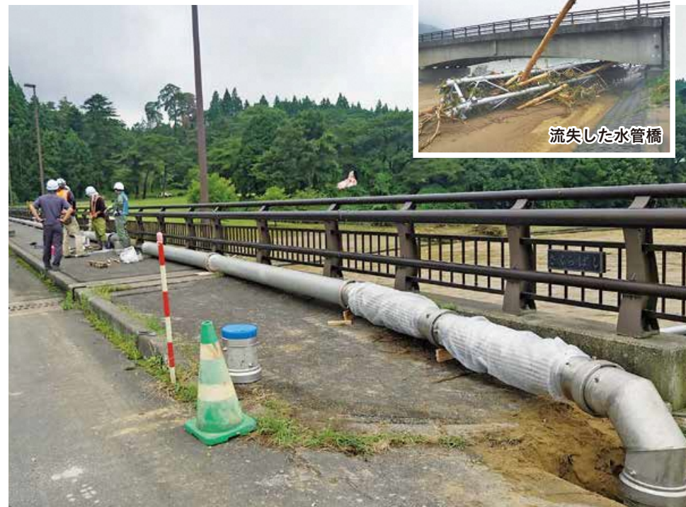
仮復旧した水道管
