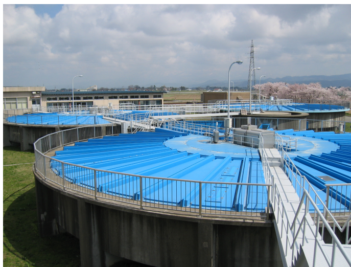
小牧浄水場 高速沈でん池
