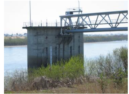
▲ 取水塔（最上川）
