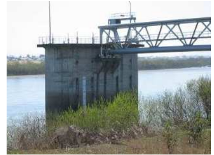
▲ 取水塔（最上川）
