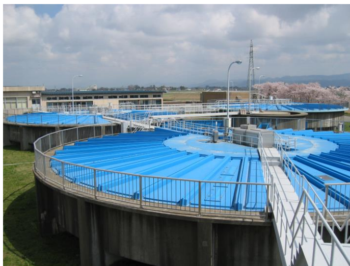
小牧浄水場 高速沈でん池
