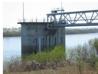
▲ 取水塔（最上川）
