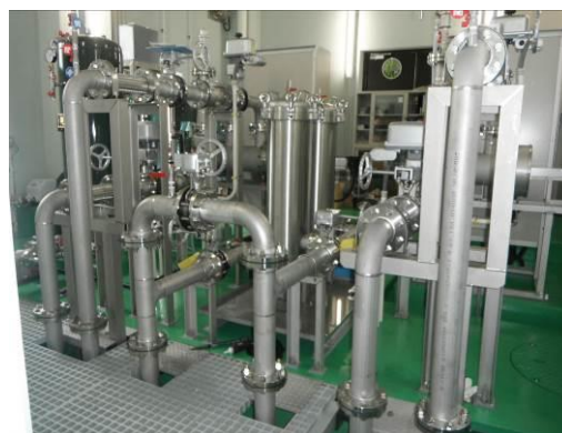
▲ 紫外線照射装置（升田水源地）
