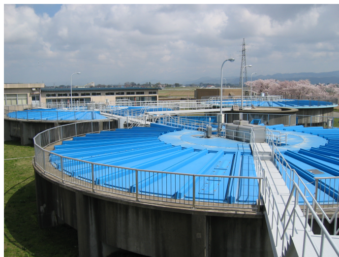
小牧浄水場 高速沈でん池
