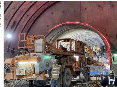
写真③:鉄道トンネル近接区間掘削状況
