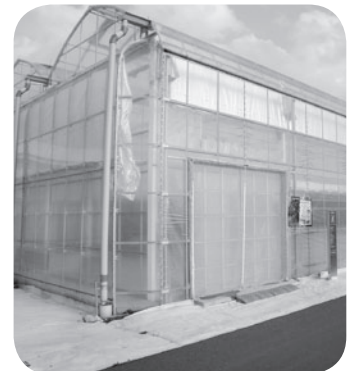
面積は1棟1,000～2,500㎡(トマト)
