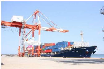
高砂ふ頭のコンテナクレーン
