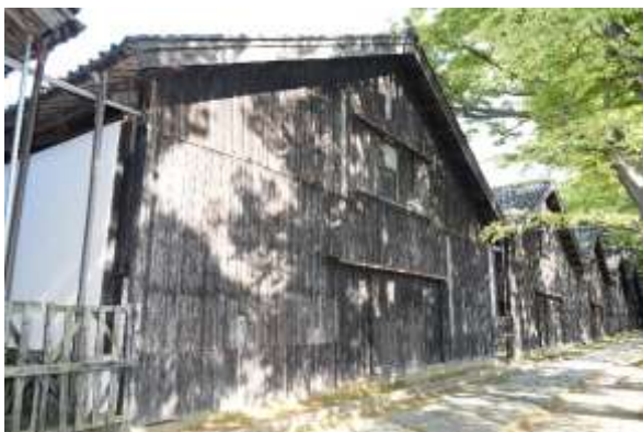
写真 5-2-3 外壁下見板
