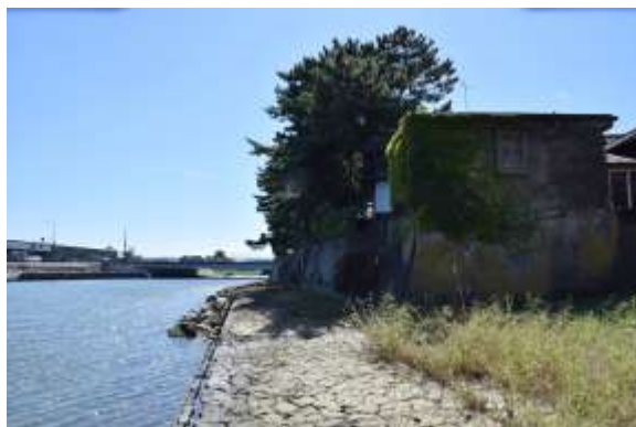
写真 5-2-7 新井田川護岸根固めの 石敷と松杭
