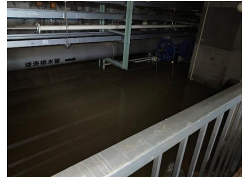
①八幡浄化センターの配管室浸水状況
