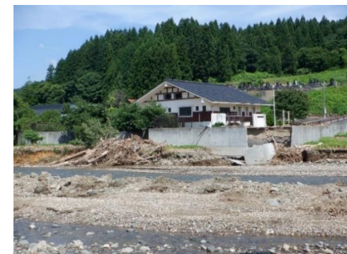
③青沢地区農業集落排水施設の擁壁崩落
