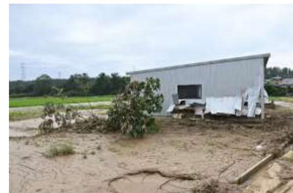
③土砂の流入により破損した車庫
