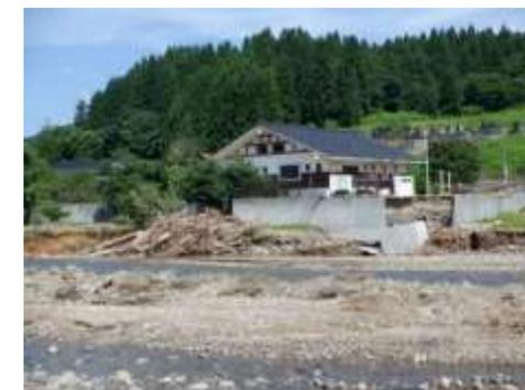
③青沢地区農業集落排水処理施設の擁壁崩落
