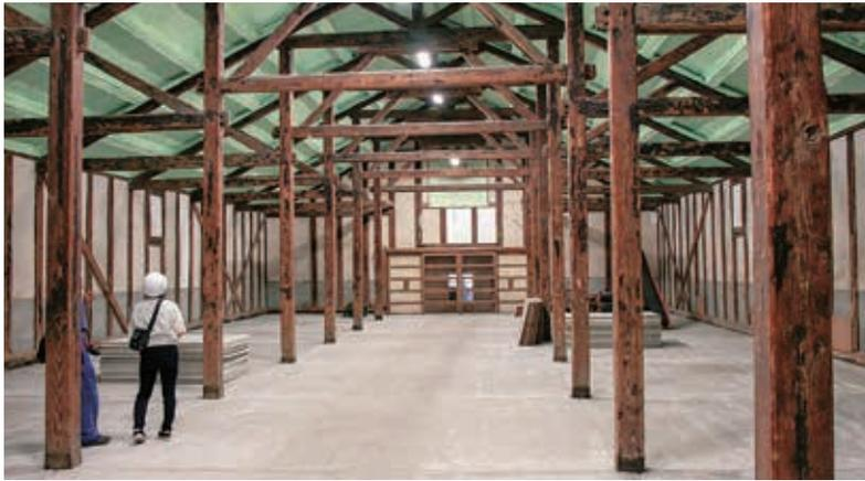
倉庫内の梁行7間半(約13.5<sup>尺</sup>)は3等分にされ、2間半の柱間に米俵10俵を収納できました。側面の斜材が庄内大地震後に入れられた大筋違
