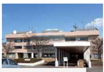
平田総合支所正面 旧平田町役場だった同支所。2階・3階には、酒田地区広域行政組合消防本部が配置されています。
