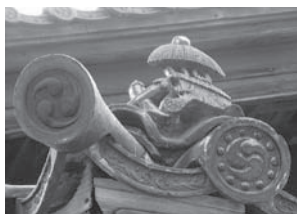
▲雨漏りを防ぐ留蓋瓦。宝尽くしのうち、隠れ笠、隠れ蓑、丁字のデザイン
