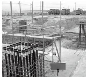
アンカーボルトと架台がユニット化され、基礎工事のスピードが格段にアップした「Dスルー工法」。当社では施工も行っています。
