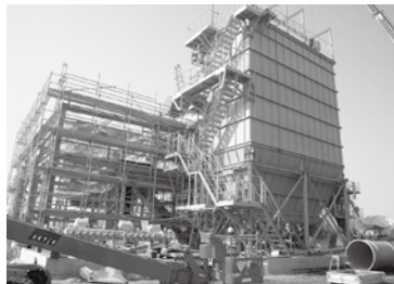
大型集塵装置の施工風景
