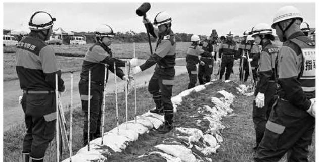
水防技術の向上を目的に「酒田市水防訓練」が最上川河川敷で行われました。当日は市内各地域の水防団を組織する消防団員ら約200人が参加し、昨年7月の大雨災害で実際に実施した積土のう工法、釜段工法を実施。大雨による警報発令を想定し、迅速・的確な対応方法を確認しました。
