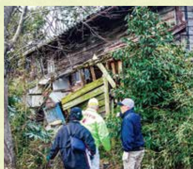
▲ 空き家の状況確認の様子
