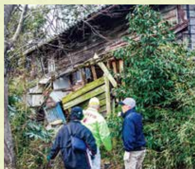
▲ 空き家の状況確認の様子
