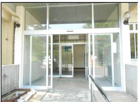
建物①内部-1
