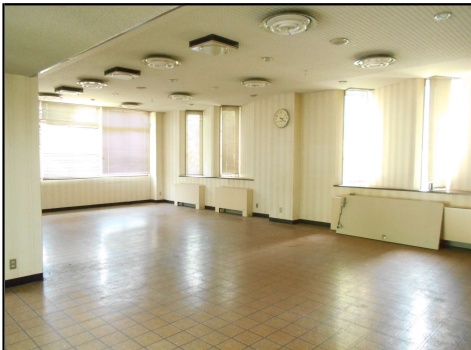
建物①内部-7
