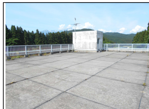
建物①屋上
