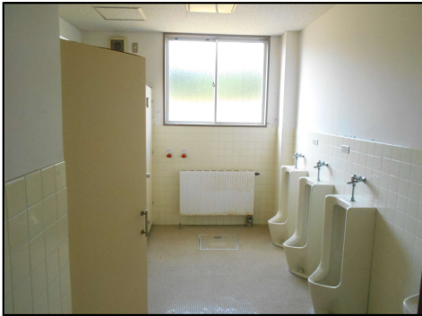
建物①内部-11
