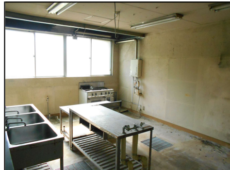
建物①内部-8
