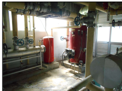
建物①内部-6
