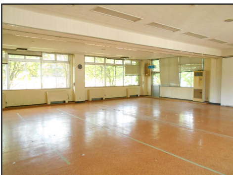
建物①内部-9
