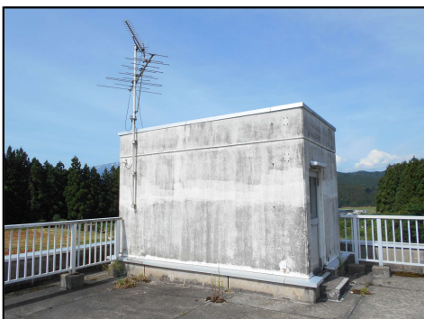
建物①塔屋
