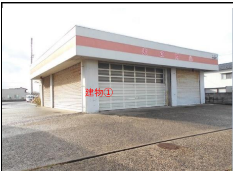
建物①外部-1
