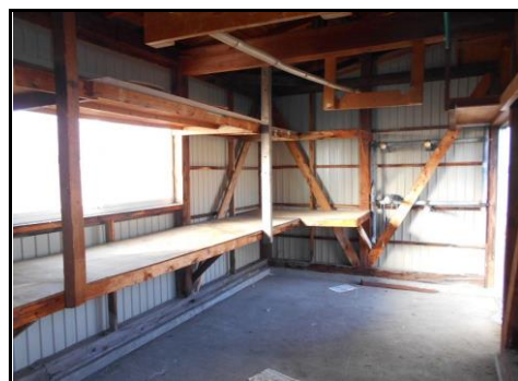
建物③内部
