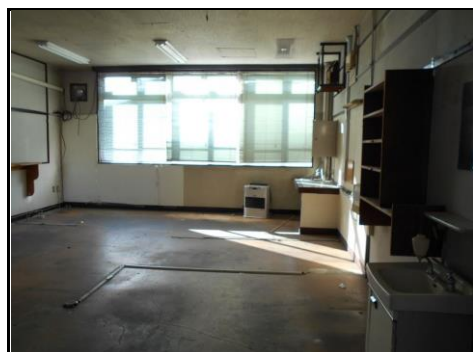
建物①内部-6
