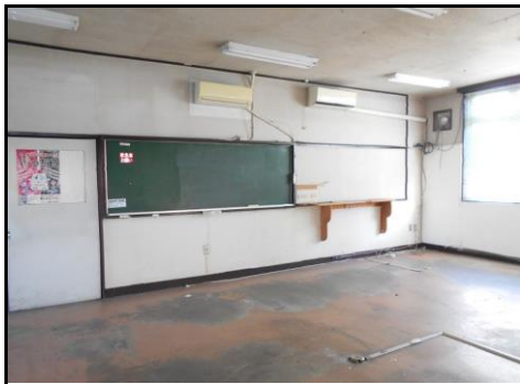
建物①内部-7
