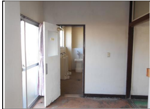
建物①内部-12
