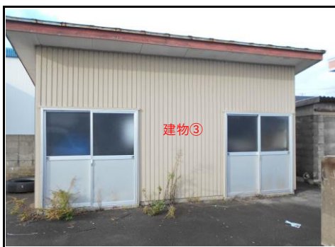
建物③外部
