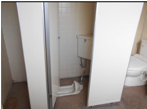
建物①内部-15
