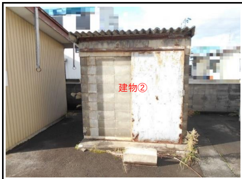
建物②外部
