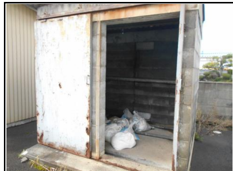
建物②内部
