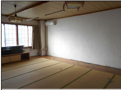
建物①内部-11
