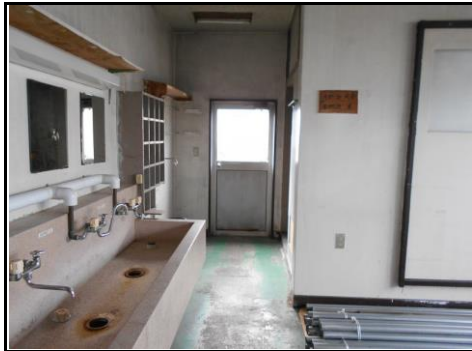
建物①内部-19
