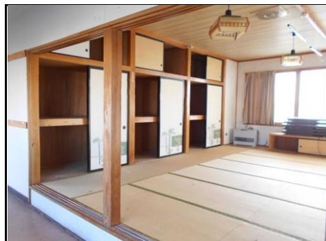
建物①内部-10
