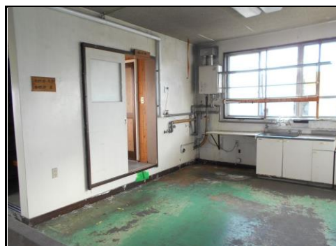
建物①内部-18
