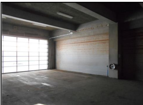
建物①内部-1
