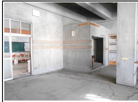
建物①内部-4
