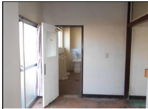
建物①内部-8
