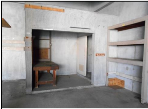
建物①内部-3
