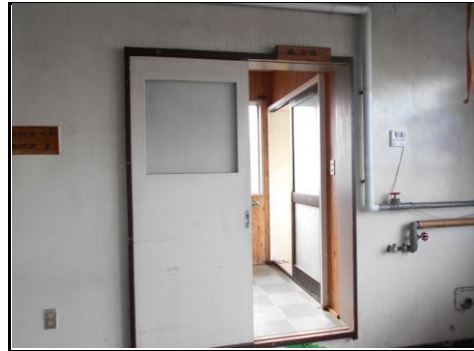
建物①内部-20
