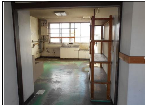
建物①内部-16
