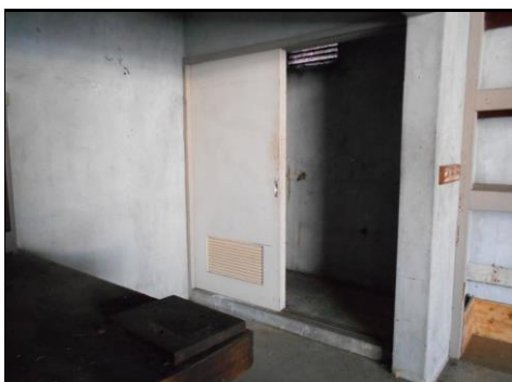
建物①内部-5
