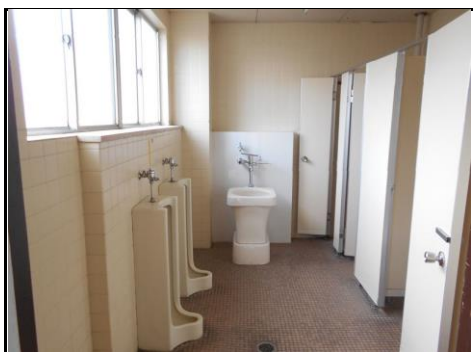
建物①内部-13
