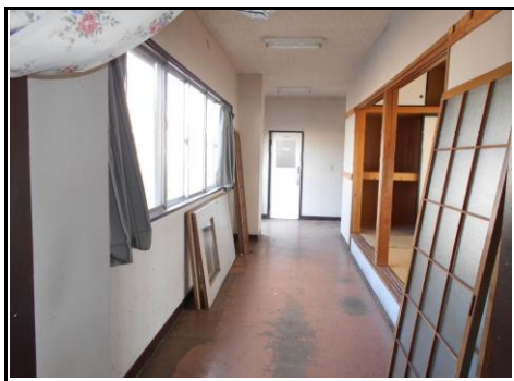
建物①内部-9
