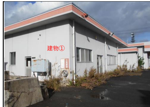
建物①外部-2
