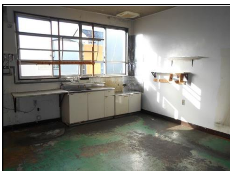
建物①内部-17
