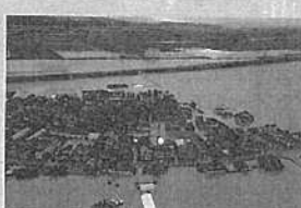
令和6年7月25日 西荒瀬地区日向川の氾濫により一帯が浸水
