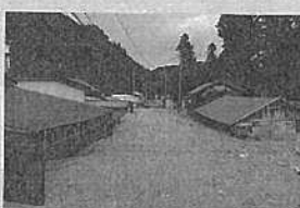
令和6年7月25日 八幡地域小笠原地区土砂流出による被害
