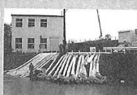
令和6年9月20日 竹田排水機場南に排水ポンプ車を配置して竹田川に吸水ホースを設置
