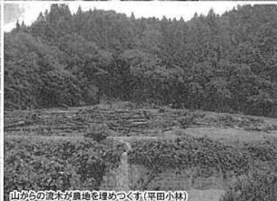
山からの流木が農道を埋めつくす(平田小林)
