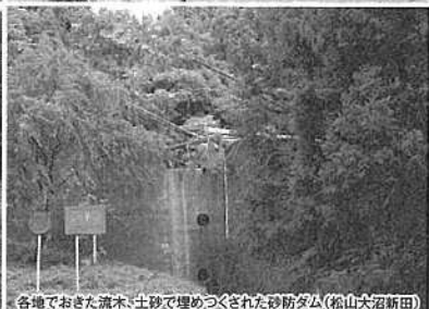
各地でおきた流木・土砂で埋めつくされた砂防ダム(松山大沼新田)
