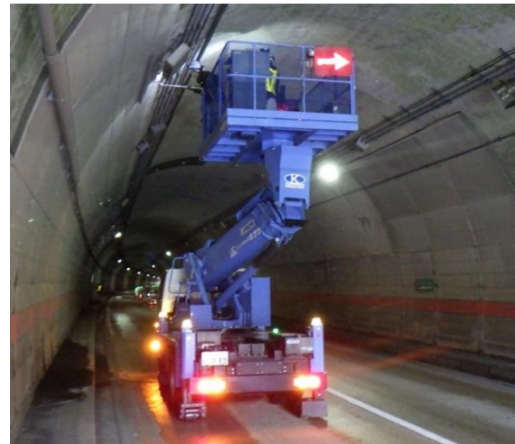
図 4-3 トンネル点検作業の例
