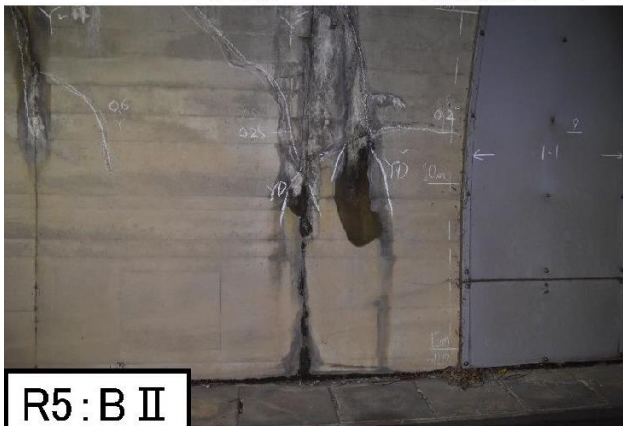
主な変状の写真（令和 5 年度点検結果）
