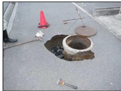
腐食による道路陥没状況
