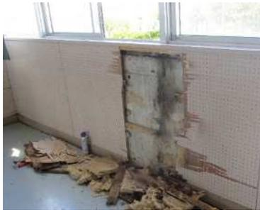
サッシ老朽化による雨漏り・腐食発生の状況
