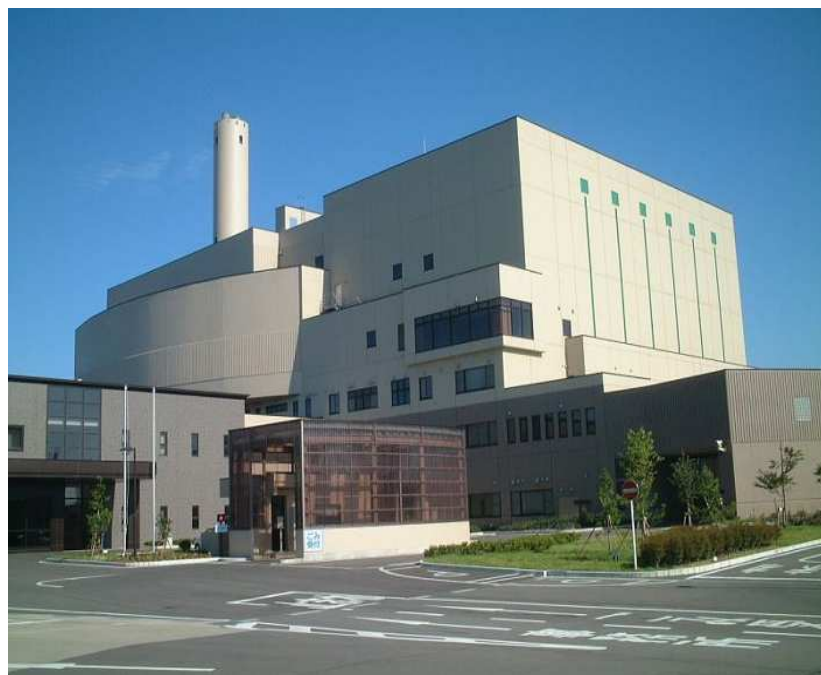
稼働中のごみ処理施設
