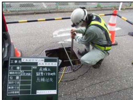
カメラ調査状況
