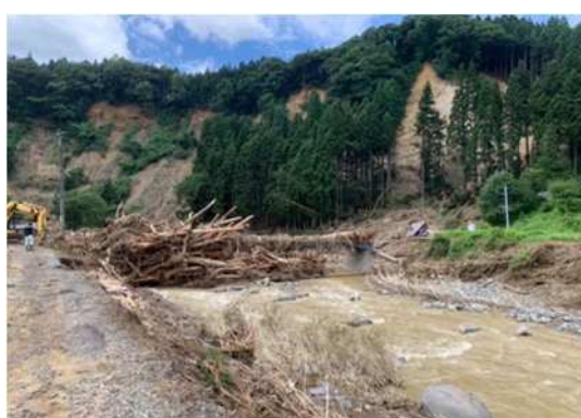
荒瀬川の越水による家屋被害（上青沢地区）
