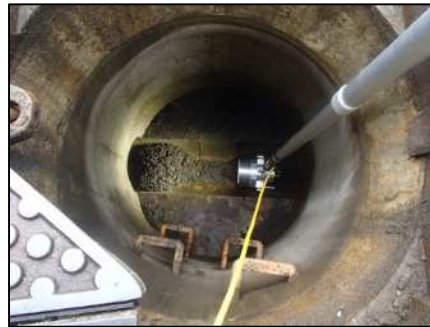
カメラ調査状況
