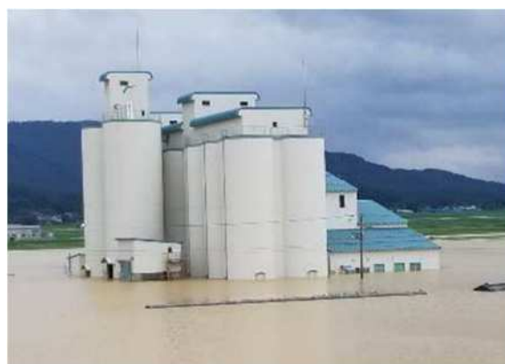
カントリーエレベーターが浸水した竹田地区
