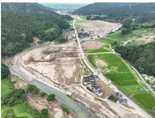
荒瀬川の越水による家屋被害（下青沢地区）
