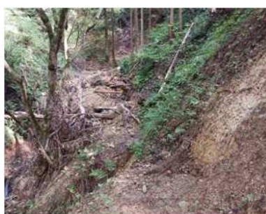
遊歩道の崩壊
