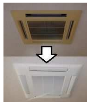
空調設備の更新
