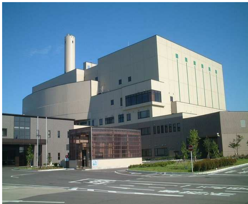
【稼働中のごみ処理施設】
