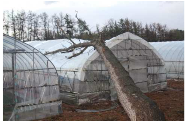
【暴風による倒木により潰されたハウス】
