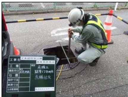
【施設の点検調査】
