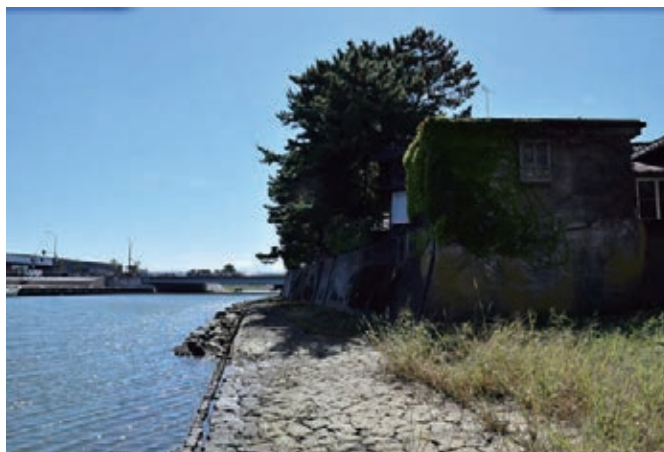
写真 5-2-7 新井田川護岸根固めの石敷と松杭
