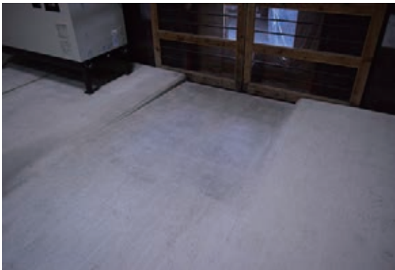
写真 5-3-1 10号棟入口スロープ
