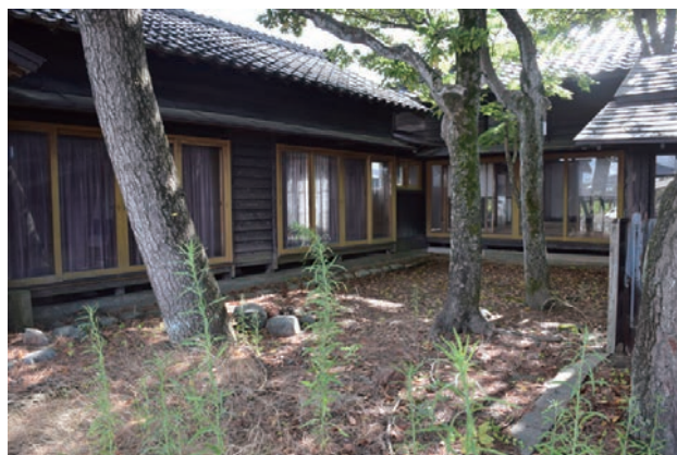
写真 5-7-5 和室東中庭（外部より）
