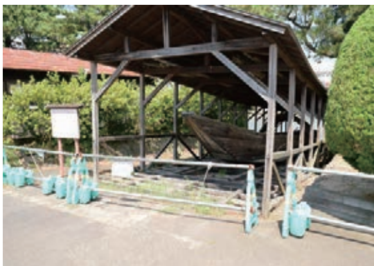
⑪荷揚場（南）
