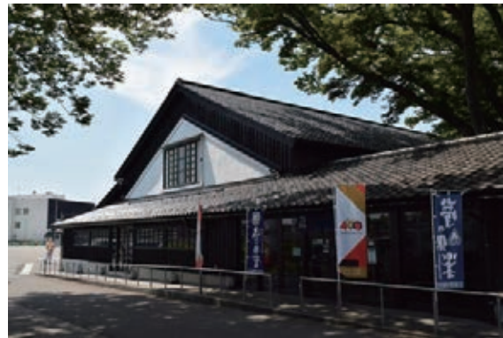
写真 5-3-2 12号棟屋外スロープ
