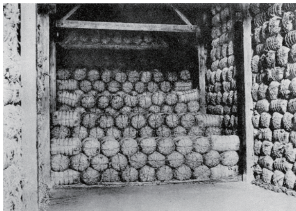
写真 5-10-1 明治期の倉庫内
