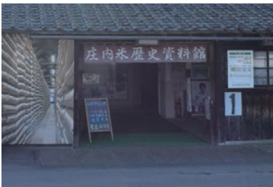
写真 5-3-3 1号棟下屋と同一の外部通路の舗装レベル
