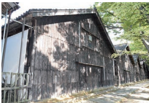
写真 5-2-3 外壁下見板
