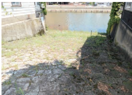
⑦荷揚場（北）
