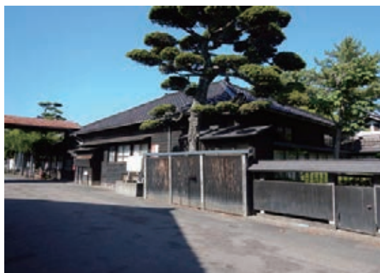
⑧事務所棟
