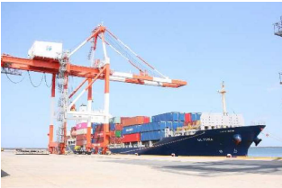
高砂ふ頭のコンテナクレーン
