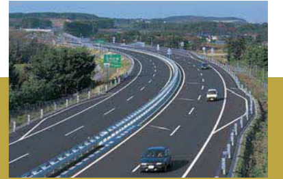
日本海沿岸東北自動車道
