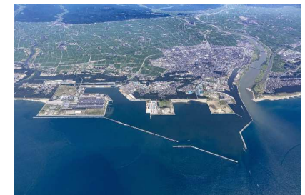
エネルギー産業が集積する酒田港の後背地 (出典：東北地方整備局酒田港湾事務所)
