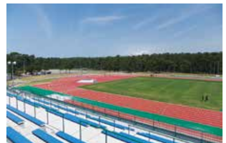
トラックを改修する光ヶ丘陸上競技場
