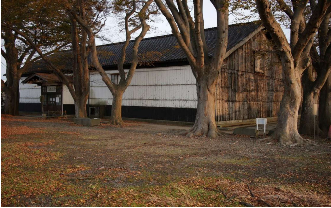
写真1 全景(北西から)
