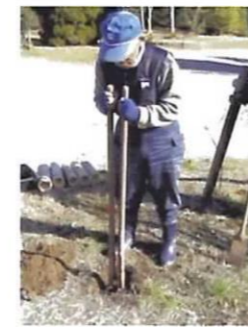
・空気管埋設
