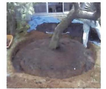
・土壌改良材を混入し埋戻し
