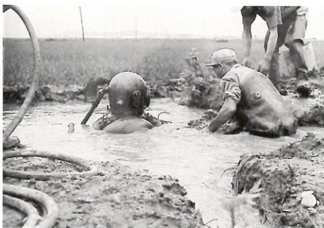
▲ 新潟地震で破損した上水道水道管修理の様子
