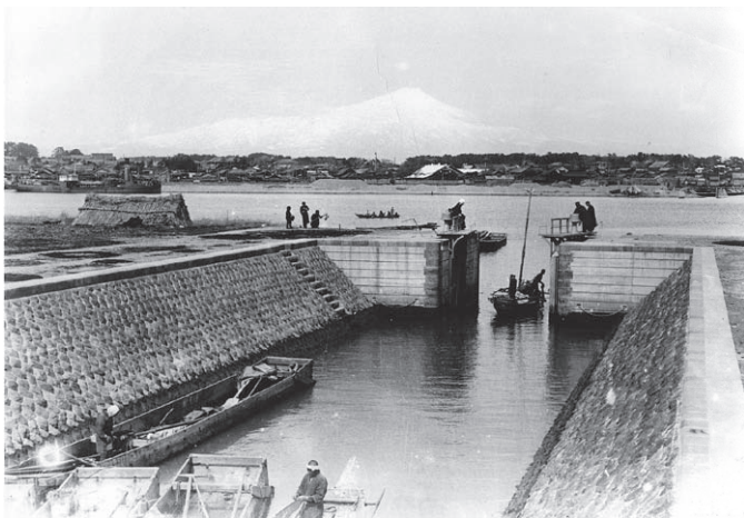
酒田港と最上川の分離工事で造られた閘門／昭和7年(1932)
