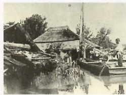
▲遊摺部落の浸水
