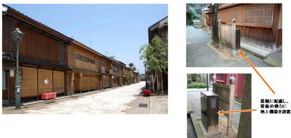
図－3 地上機器を私有地に設置した事例（出典：国土交通省HP）
