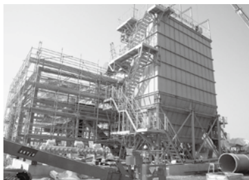
大型集塵装置の施工風景
