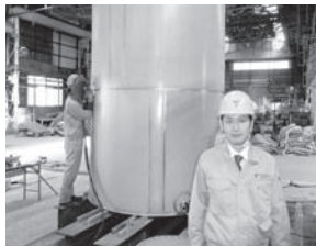
工場内でのステンレス製タンクの溶接作業風景
