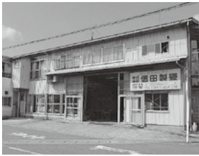
本社・第一工場
