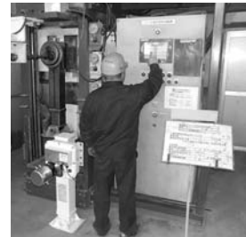
補助脚の荷重試験
