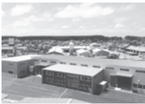
本社工場(平成27年7月竣工)
