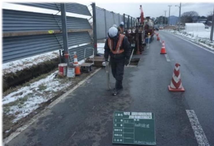
写真4-5 処理区間を結ぶ接続管路の施工状況
