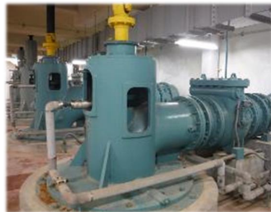
写真2-3 中継ポンプ場とポンプ本体
