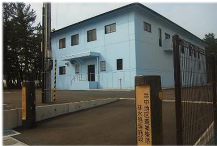
写真2-2 真空式システムの浜中地区農業集落排水処理施設
