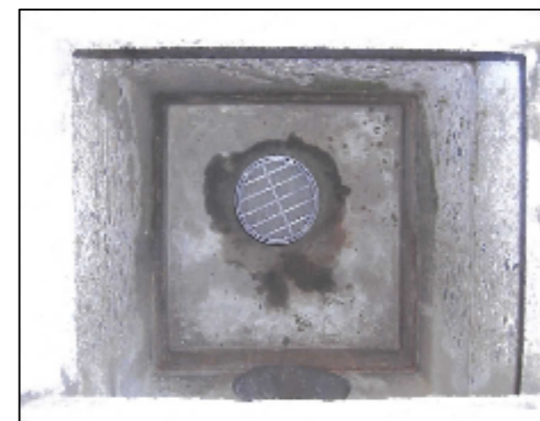
既設雨水ますの浸透ます化
